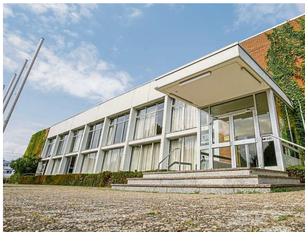
Die alte Sport- und Kulturhalle in Seeheim wird abgerissen und durch eine neue ersetzt. Vor allem die Sportvereine sorgen sich nun um die mögliche Innenausstattung. Archivfoto: Torsten Boor
